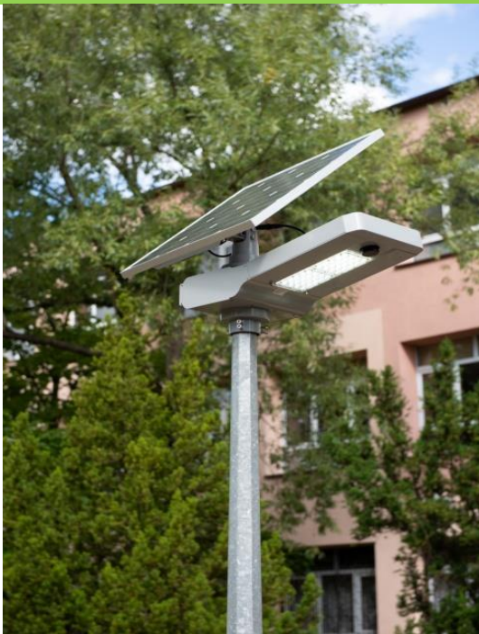
Lámpatest fotovoltaiikus panellel felszerelve Bydgoszcz-ban, Lengyelországban
