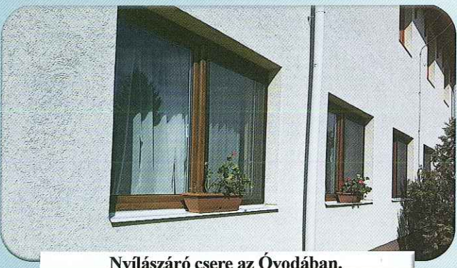
Nyílászáró csere az Óvodában.
