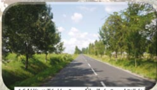
A felújított Tápiógyörgye Újszilvás összekötő út.
