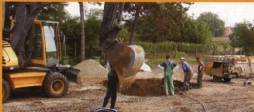
Kútakna építése
