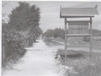
Épülő az új kerékpárút
