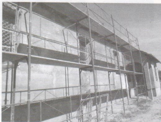
Római katolikus templom felújítása
