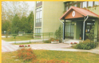
Az akadálymentesített iskola bejárata
